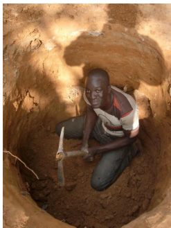
Creusement du puisard
