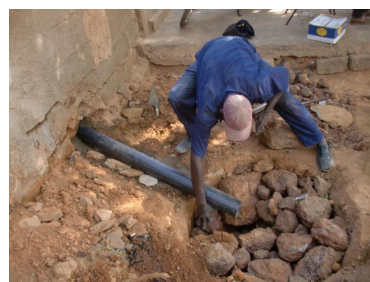
Pose des moëllons et du tuyau d'évacuation
